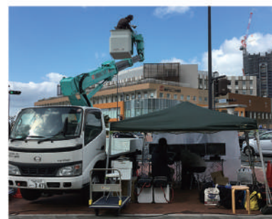
撮影現場での電源確保
