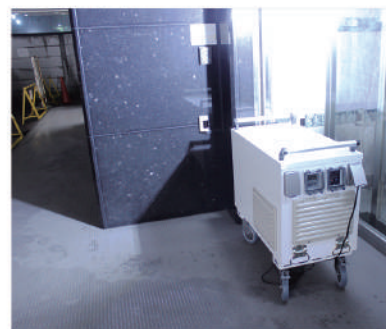
夜間作業での電源確保
