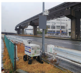
屋外計測機器の電源確保
