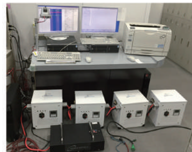
法定停電での電源確保
