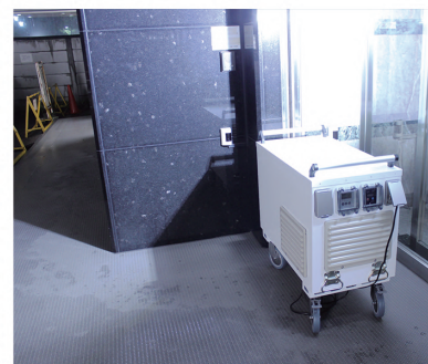
夜間作業での電源確保
